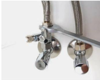
› Schrauben Sie den zuvor entfernten Flexschlauch auf den oberen Teil des Wasseranschlusses.
