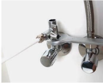
› Montieren Sie den Wasseranschluss auf das Eckventil.
