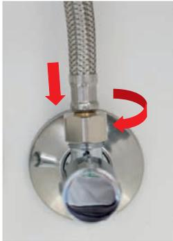
› Schrauben Sie nun den Eingangsschlauch auf den Wasseranschluss.
